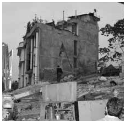
Eingestürzte Häuser in Nepal Foto: Lutheran World Foundation (LWF)
